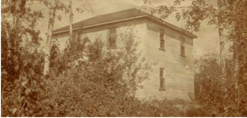
La maison sur le 10.
