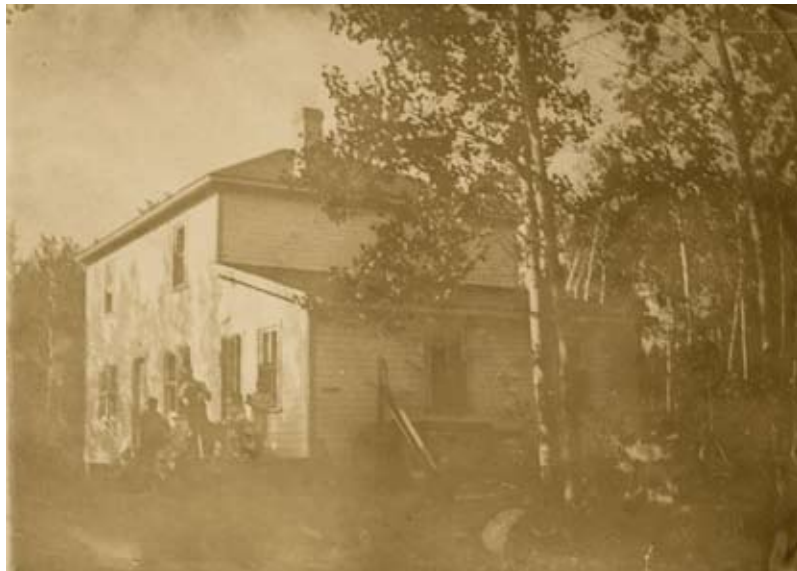
La maison sur le 10.
